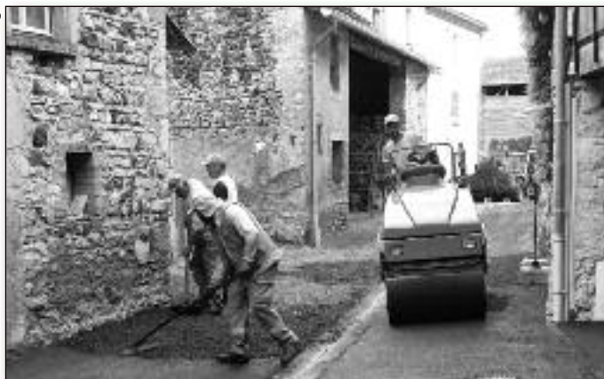
Travaux rue du Château
