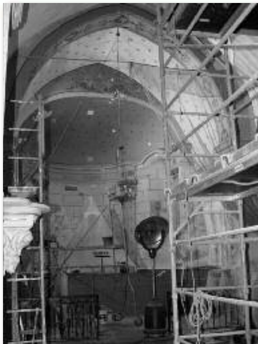
Les travaux de refecton de l'église
